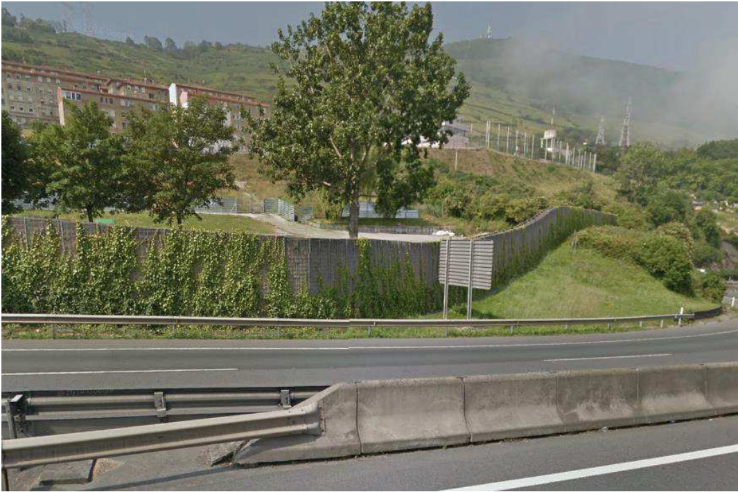
Figura 12: ejemplo de pantalla vegetal en proceso de crecimiento de la vegetación.
