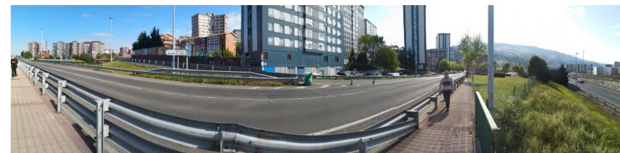
Fotografía nº6. Panorámica de la zona de acceso y localización del enlace.
