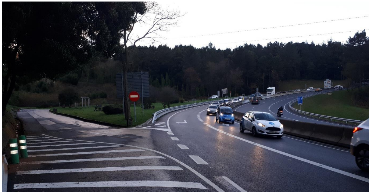
FIGURA 2. VISTA DE LA INCORPORACIÓN DESDE EL ÁREA DE DESCANSO
