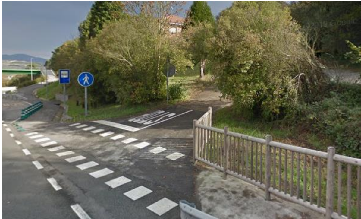
FIGURA 8. VISTA DEL ACCESO EN EL P.K. 7+350.
