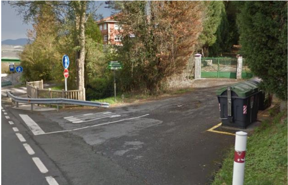
FIGURA 7. VISTA DEL ACCESO EN EL P.K. 7+330.
