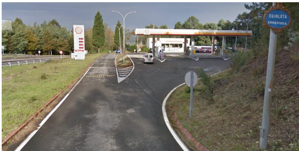
FIGURA 4. VISTA DEL ACCESO A LA GASOLINERA.
