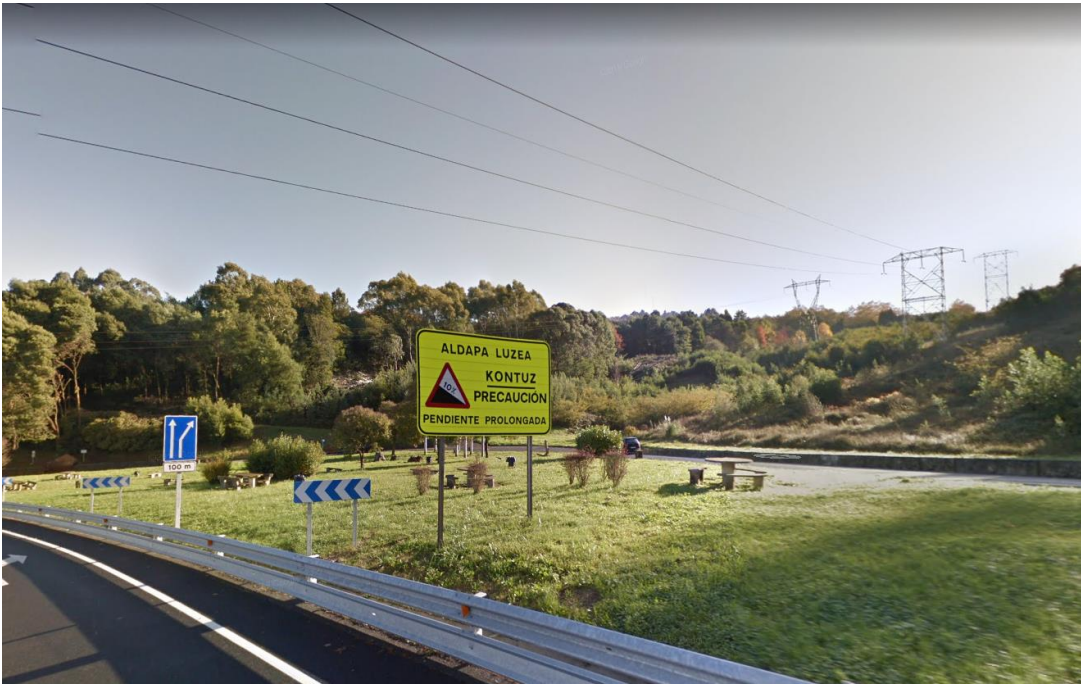
FIGURA 14. LÍNEAS DE ALTA TENSIÓN
