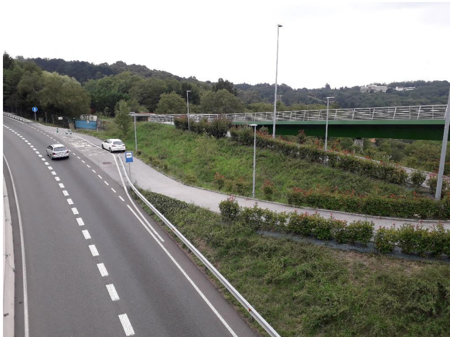
FIGURA 3. ALUMBRADO PASARELA. SECTOR OESTE
