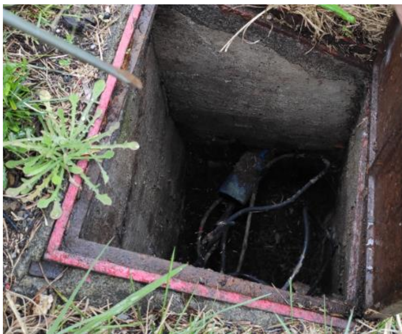
FIGURA 19. ARQUETA ELECTRICIDAD GASOLINERA Y CRUCE DE CALZADA
