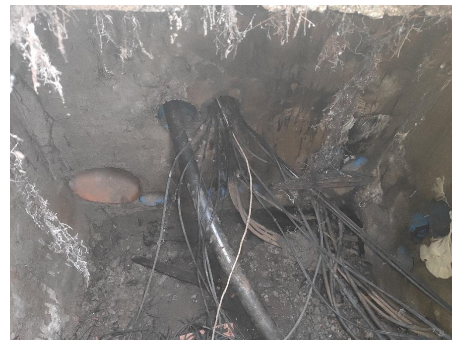
FIGURA 16. ARQUETA 2 CONJUNTA ELECTRICIDAD-ABASTECIMIENTO
