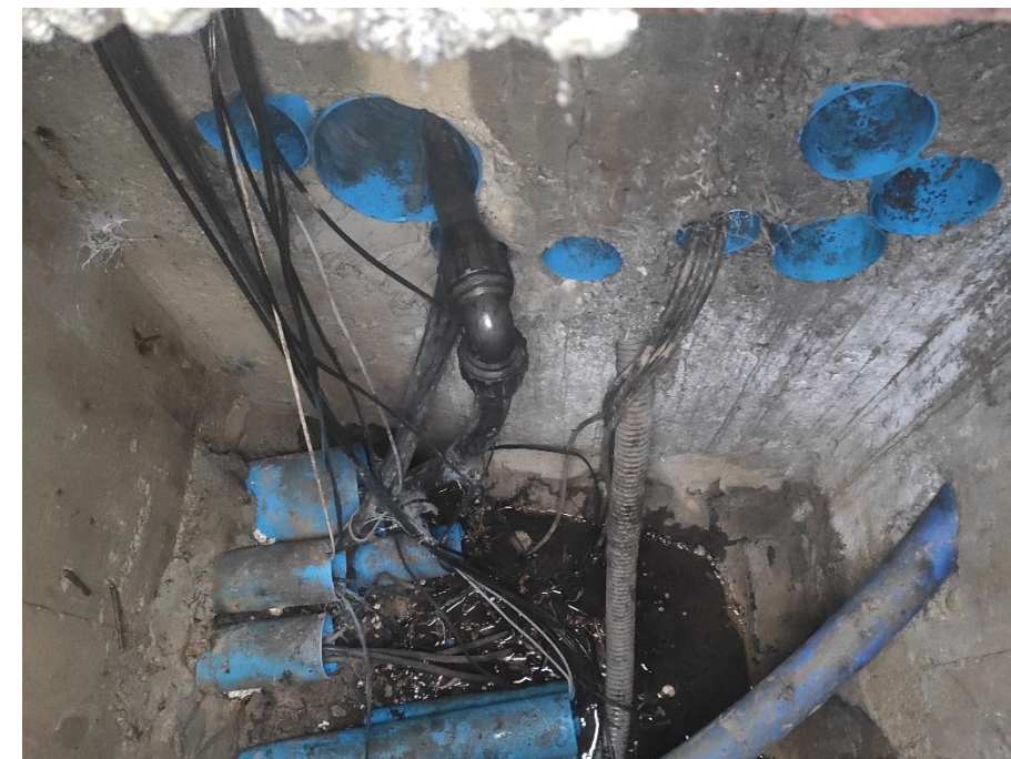
FIGURA 15. ARQUETA 1 CONJUNTA ELECTRICIDAD-ABASTECIMIENTO
