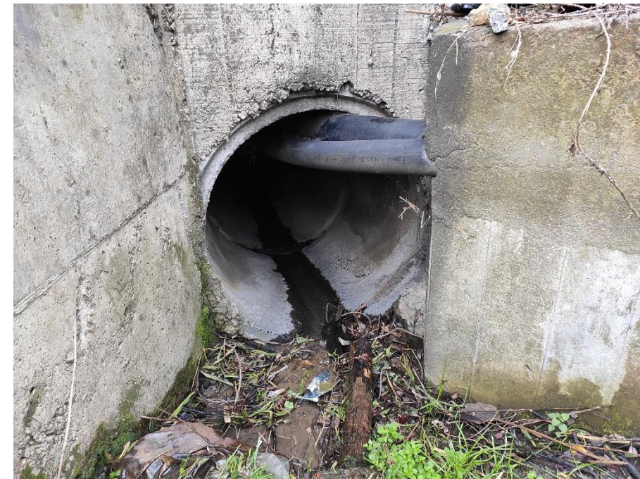
FIGURA 1. PASO BAJO CALZADA EN OBRA DE DRENAJE
