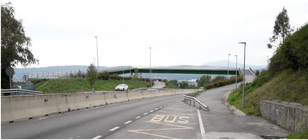
FIGURA 3. VISTA DE LA PASARELA EGIRLETA. DESDE LA PARADA DE BUS DE LA MARGEN DERECHA.
