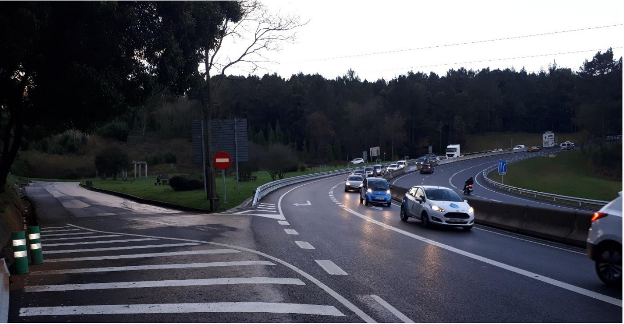
FIGURA 5. INCORPORACIÓN ACTUAL DESDE EL ÁREA DE SANTO DOMINGO.
