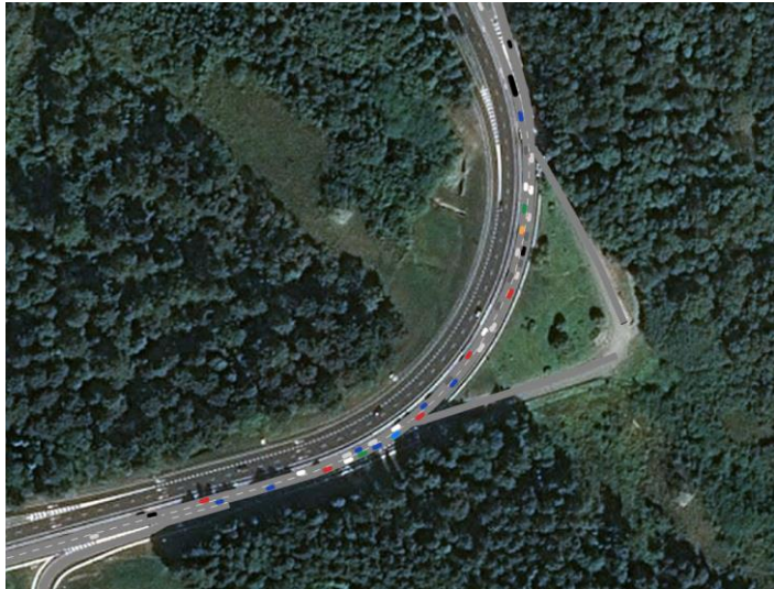
FIGURA 17. IMÁGEN DE LAS COLAS DE VEHÍCULOS EN SITUACIÓN ACTUAL
