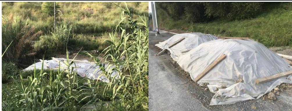
Acopio de tierra vegetal cubierto
