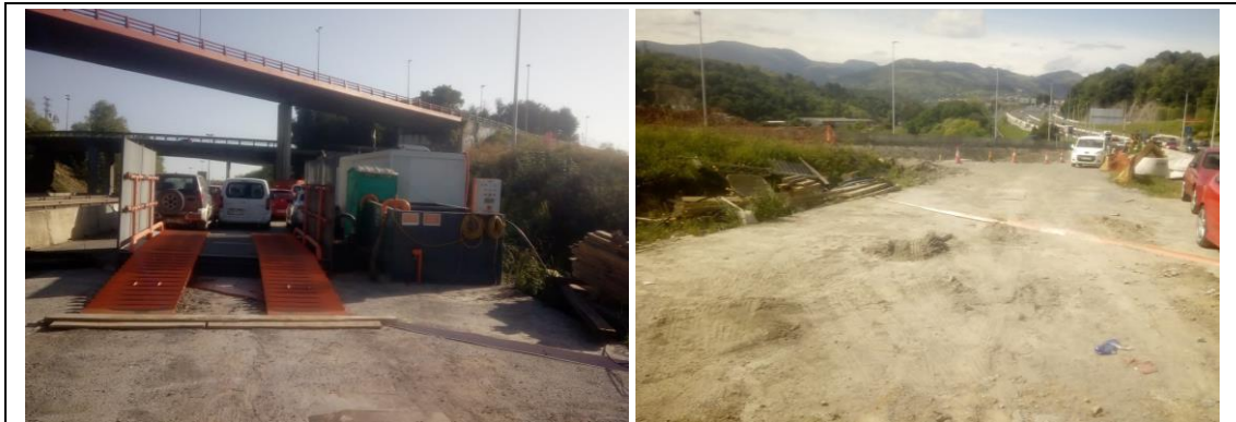
Zona del lavarruedas antes y después de su retirada (14 y 22/04/2021)
