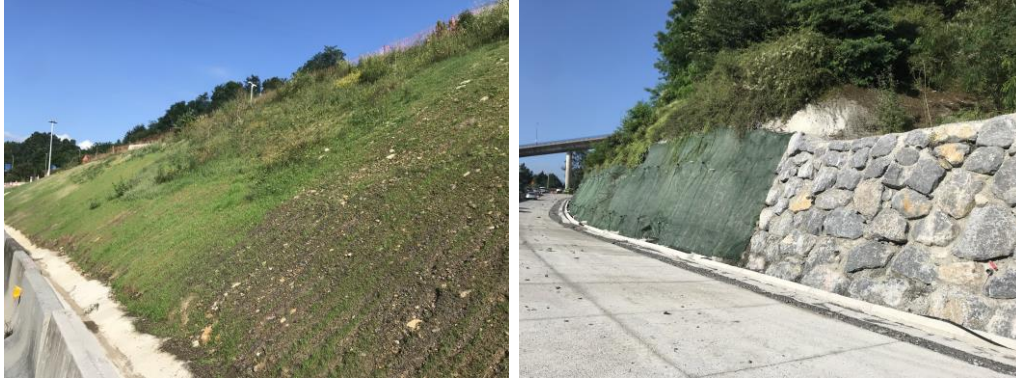
Talud hidrosebrado y malla colocada junto a la escollera del Muro 7
