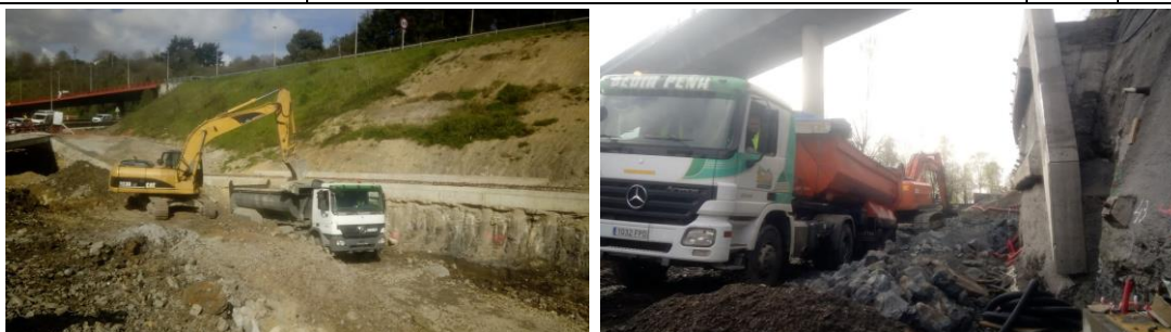
Zona de excavación en los ejes 7 y 3
