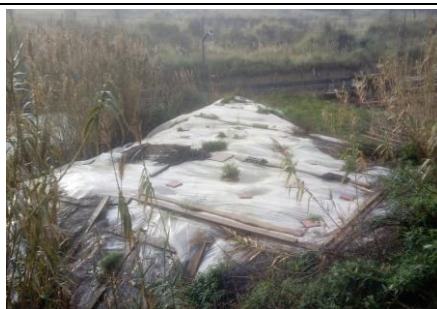
Acopio de tierra vegetal cubierto
