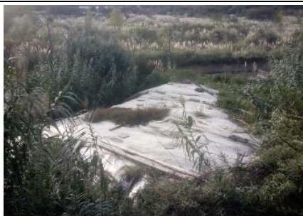
Acopio de tierra vegetal cubierto
