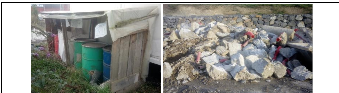
Punto limpio y acopio de restos de hormigón
