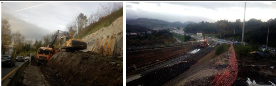
Zona de excavación en los ejes 7 y 3
