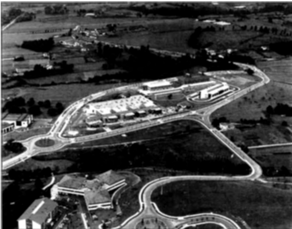
Fotografía aérea. Parque Tecnológico de Zamudio.
